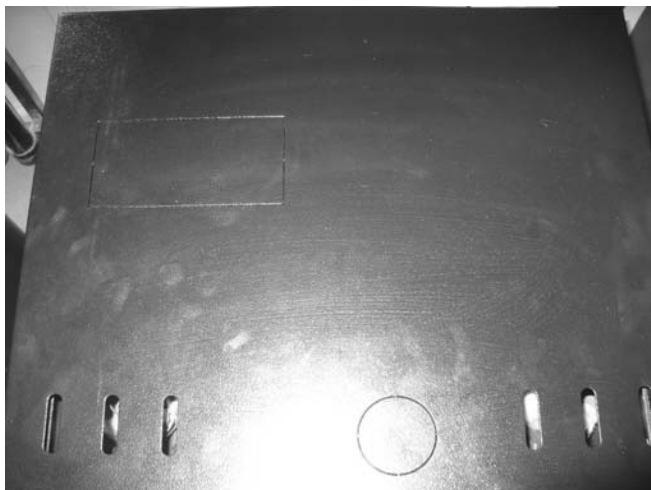
2. Wybić okrągłą zaślepkę w górnej obudowie kotła (należy to uczynić delikatnie, aby nie zniszczyć obudowy). Uwaga: zadziory pozostałe na krawędziach otworu należy dokładnie spłować pilnikiem.
